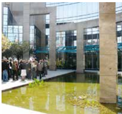
Architektonisch hochwertige Versiegelung
